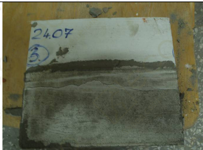
Фото 18. Видна горизонтальная трещина в полке на всю длину образца с наклоном в сторону опорной зоны.
