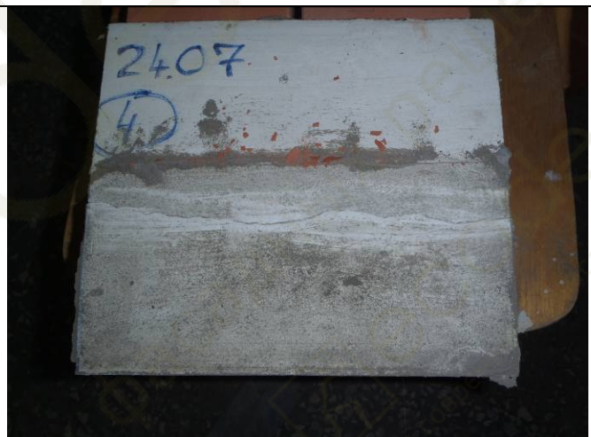
Фото 22. Горизонтальная трещина в полке на всю длину образца УГ 1-4 с наклоном в сторону опорной зоны.
