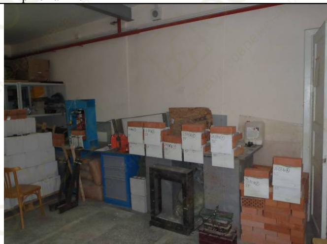
Фото 3. Для проведения испытаний по определению оптимального консольного свеса декоративных накладок-уголков предварительно выполнены образцы из испытываемых уголков и полнотелого кирпича (по 3 шт.) на цементно-песчаном растворе.
