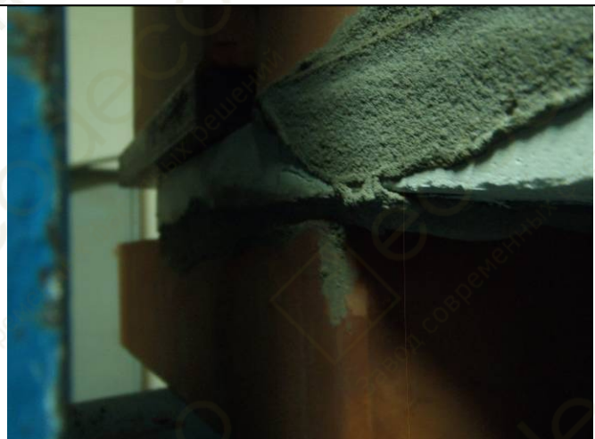
Фото 24. Осмотр дефектов после разрушения образца. Видна наклонная трещина в стенке образца.
