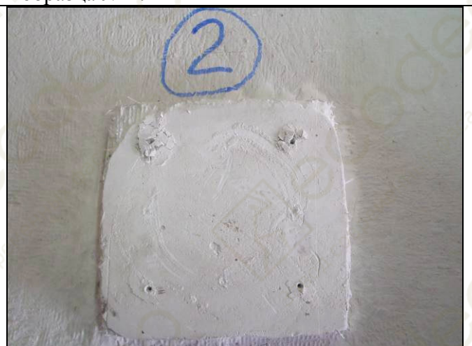
Фото 12. Испытание крепежного подвеса потолочной панели из фиброгипса. Испытание №2. Крепление на 4 шурупах. Вид образца после испытаний. Вырыв шурупов.
