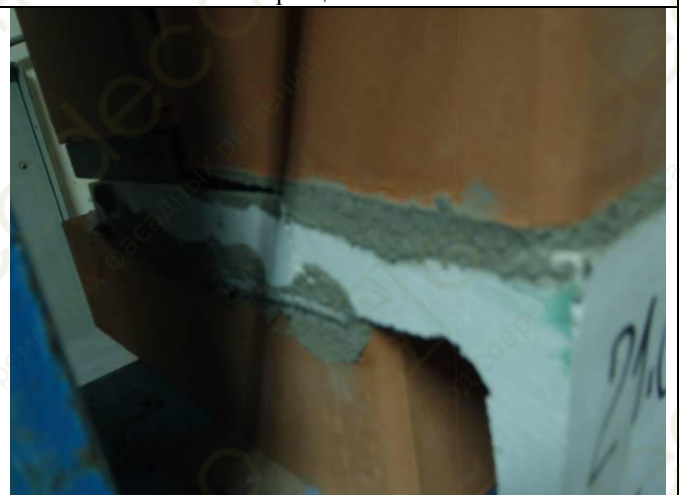
Фото 30. Осмотр дефектов после разрушения образца. Видна наклонная трещина в полке уголка шириной 1,5-2 мм с наклоном в сторону опорной зоны.
